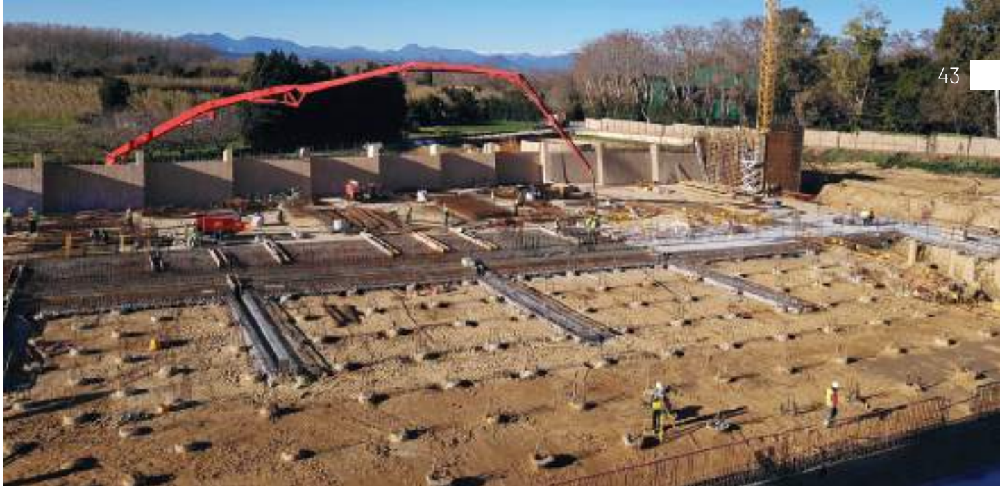
Figura 4. Execució dels fonaments.
