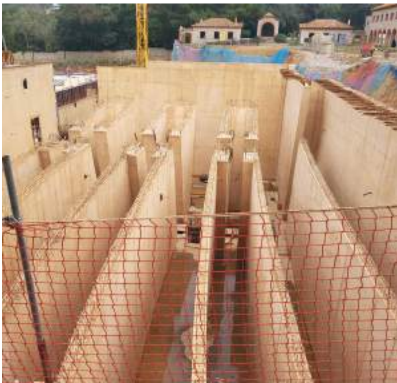
Figura 16. Murs de garbet en construcció.
