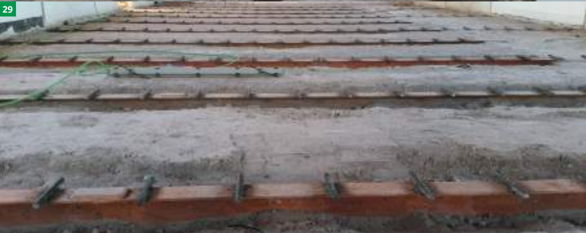
Figura 27. Pati de La Granja. Figura 28. Sostre de les cavaleries. Figura 29 Sostre de la botiga.
